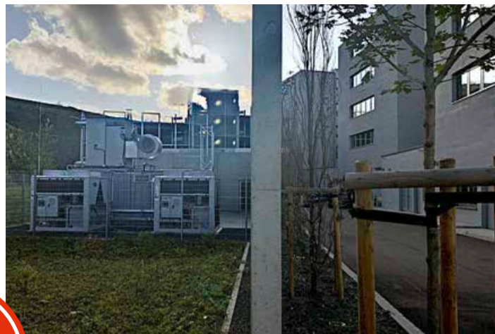
Die Energiezentrale links ist vom Gebäude durch eine Sichtschutzwand (Mitte) getrennt
